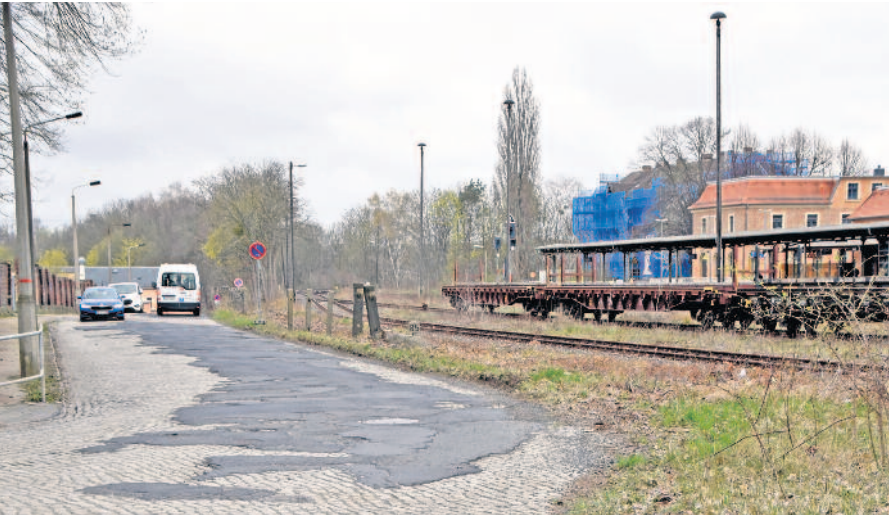
Die Holperpiste Güterbahnhofstraße wird derzeit umfassend saniert. Aufgrund einiger im Vorfeld nicht planbarer Verzögerungsquellen verlängert sich die Bauzeit um 8 bis 10 Wochen.
