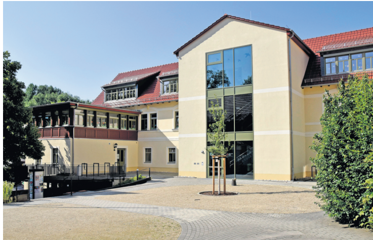
2024 konnten die Arbeiten an der ehemaligen Silberdiele abgeschlossen werden. Durch die Sanierung entstand nicht nur eine Begegnungsstätte, sondern auch das neue Domizil des Kinderhortes.
