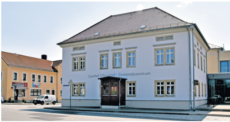
Im Ortsteil Ullersdorf erstrahlte der alte Gasthof 2019 in neuem Glanz. Durch die Sanierung wurde ein Gemeindezentrum aus dem historischen Gebäude im Ortszentrum.
