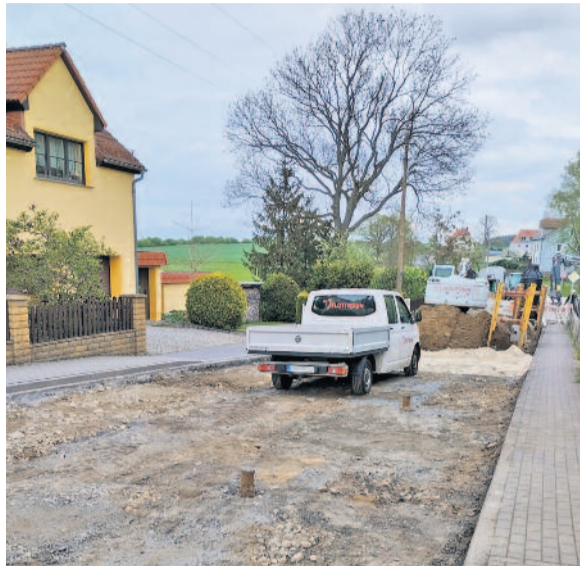
Der Straßenbelag wurde bereits abgefräst. FOTOS: Gebauer
