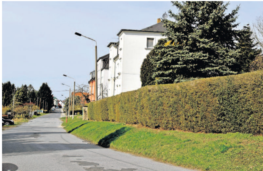
Entlang der Kleinwolmsdorfer Straße angesiedelte Wohnhäuser entsorgen ihr Abwasser bisher dezentral, das heißt über Kleinkläranlagen.
