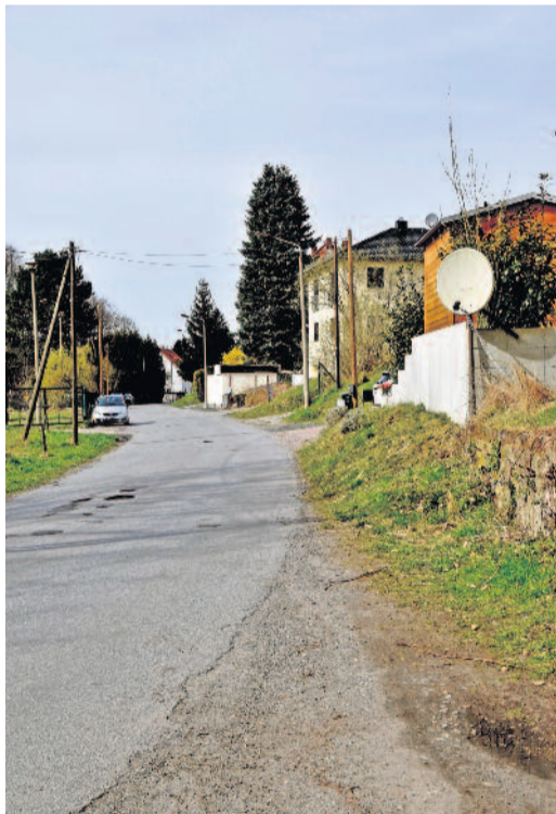
Ab Mai beginnen die Bauarbeiten, um die Kleinwolmsdorfer Straße an das städtische Abwassernetz anzuschließen.
