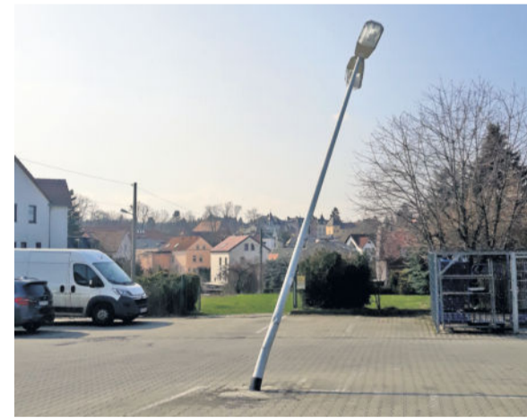
Bis vor Kurzem sah der Lichtmast so aus.
