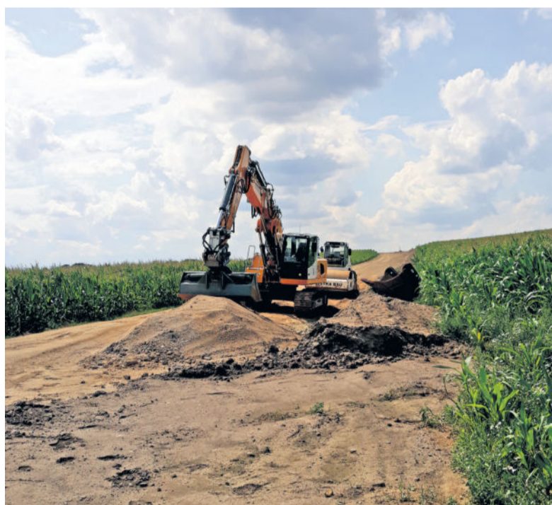
Auf dem Feldweg von Langebrück bis zur Bergsiedlung in Weixdorf laufen die Bauarbeiten. FOTO: Gebauer
