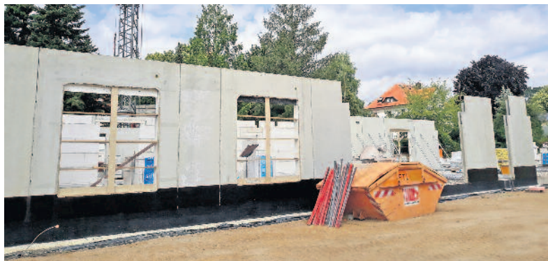
Die Arbeiten am Rohbau laufen derzeit.
