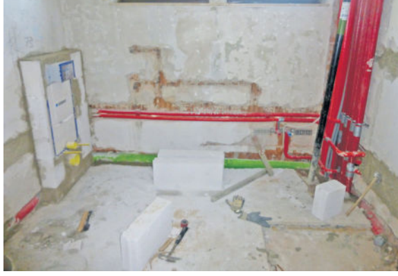
Es lohnt sich im Frühjahr und Sommer energetische Sanierungsmaßnahmen in Angriff zu nehmen.
