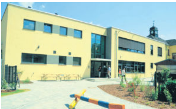
Moderner Neubau: Auch die Außenflächen sind nun fertig gestaltet.
