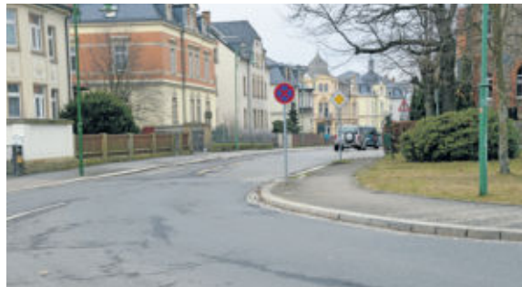
Die Dr.-Rudolf-Friedrichs-Straße ist einer der schlimmsten Holperpisten Radebergs.
