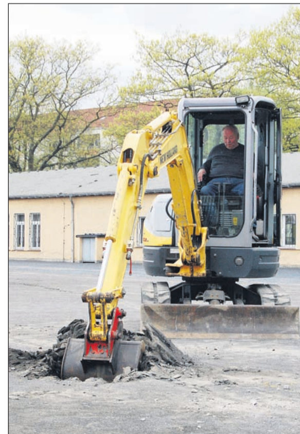
Erster symbolischer Baggeraushub durch den Geschäftsführer des Radeberger Sportverein Herrn Klaus Vienzen.
