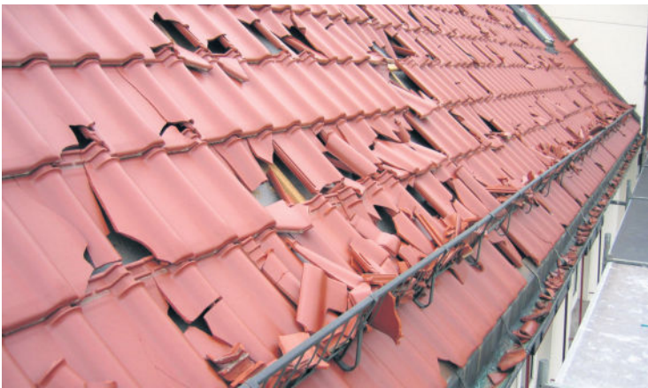
Foto: djd/Paul Bauder: Unwetter mit Hagelschlag können erhebliche Dachschäden verursachen. Die richtige Dämmung und Abdichtung darunter können schlimmere Folgeschäden verhindern.
