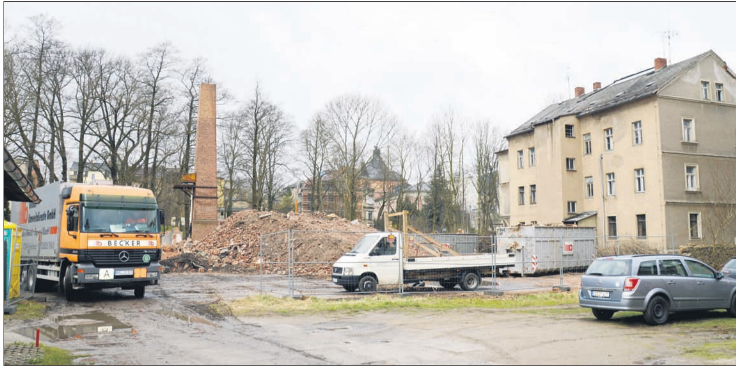
Auf den Foto oben sind die alten Gebäude der Druckerei bereits abgerissen und rechts im Bild ist die Villa zu sehen. Zum Vergleich das untere Foto, vor dem Abriss im vergangenen Jahr.
