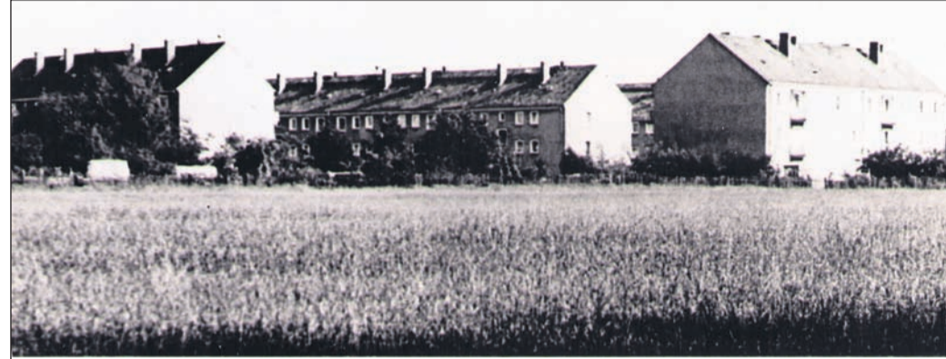
Teilansicht von 1979 der Wohnsiedlung Rossendorf. Erbaut 1963 - 1964 Block 35 - 39: März 1964; Block 25 - 29: Juni 1964; Block 41 - 43: August 1964; Block 31 - 33: Dezember 1964
