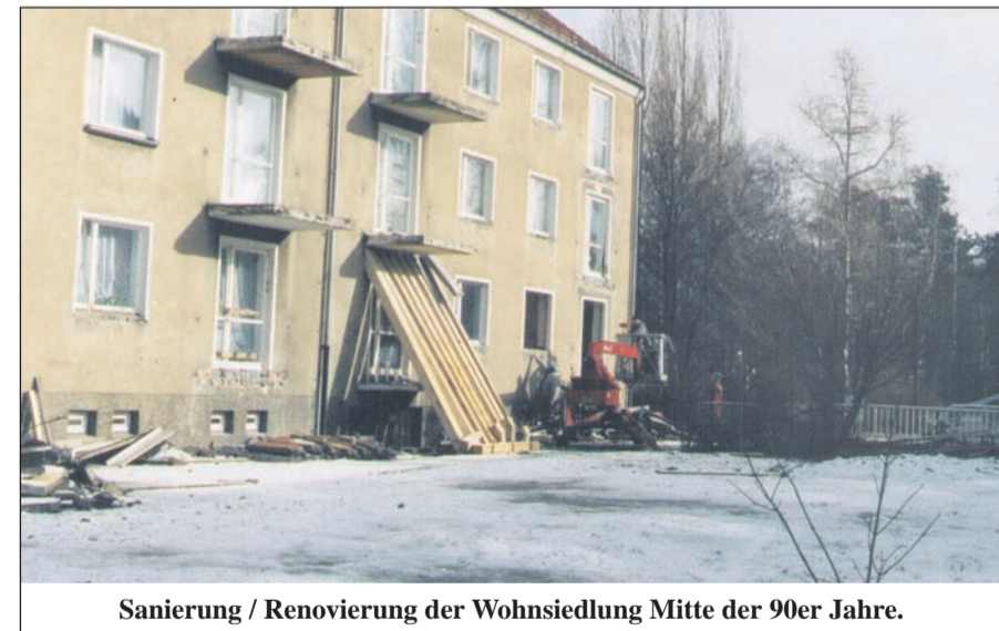
Dezember 1995 - Januar 1996: Abbruch der alten Balkonplatten am Haus 35.
